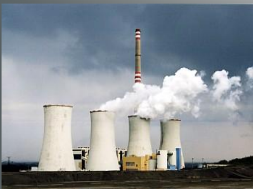
Tepelná elektrárna Chvaletice
